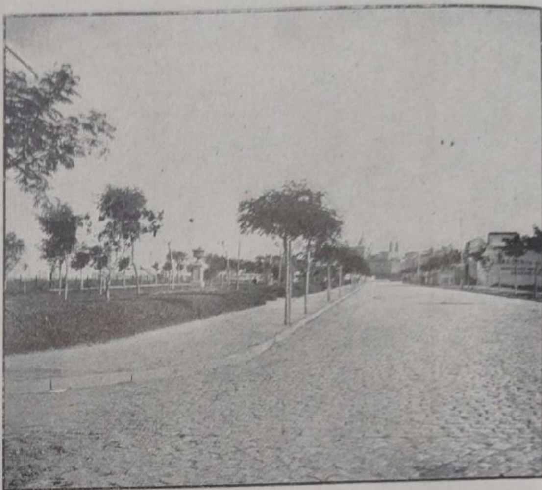
LA AVENIDA BELGRANO (EN CONSTRUCCIÓN)
