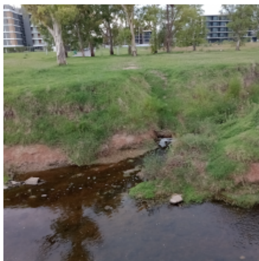
Emisario 4- Alippi descargando en Arroyo Ludueña
