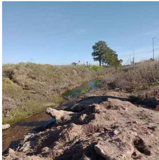
Punto 1. Conducto pluvial de la ciudad de Funes
