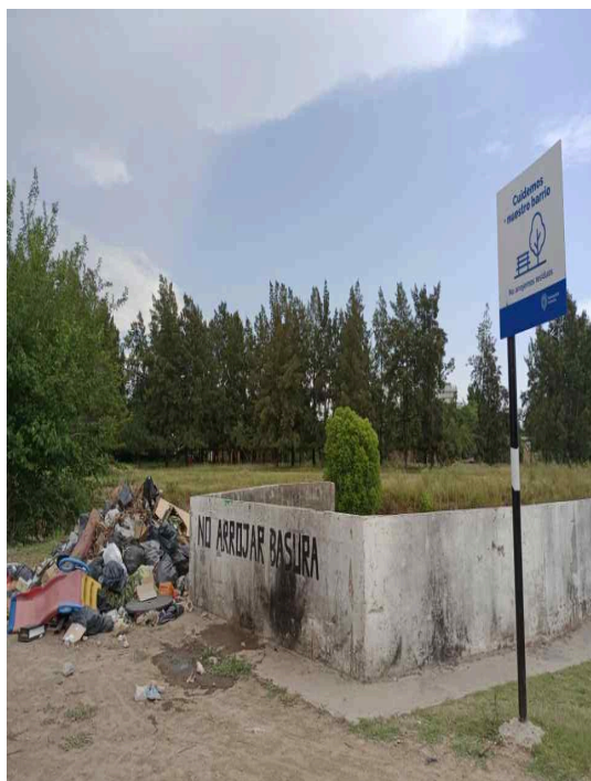
Punto E27-1. Vista del Emisario rodeado de residuos.
