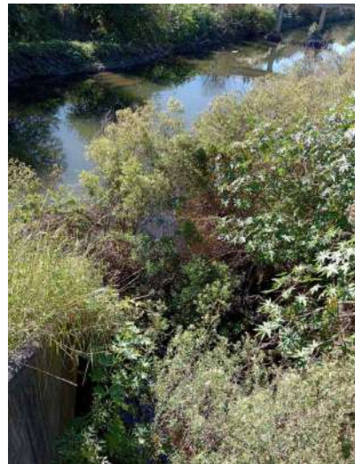
Punto E24-1. Descarga Emisario 24. Presencia de abundante vegetación
