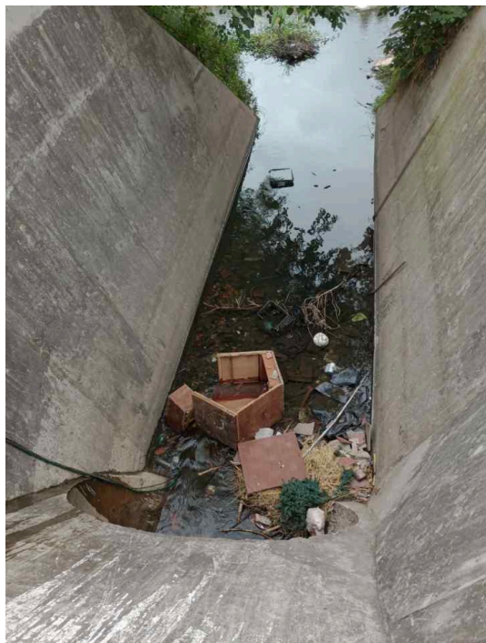
Punto E28-1. Vista del interior del Emisario
