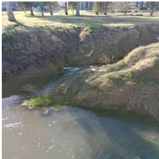
Punto 1- Vista de la descarga del emisario 4
