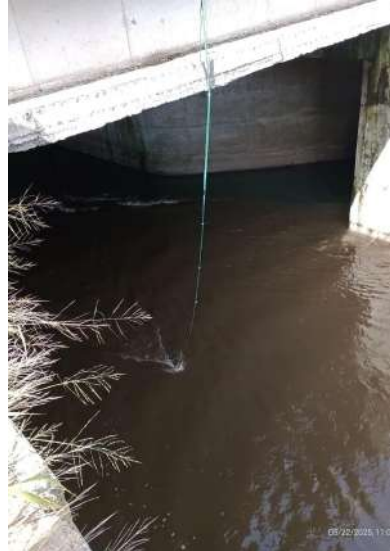
Punto ENT-1- Inicio entubamiento - Toma de muestra n°7
