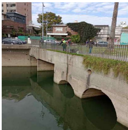
EN-3 Final del entubamiento
