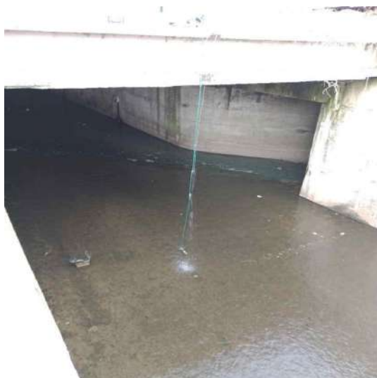
EN-1 Inicio del entubamiento
