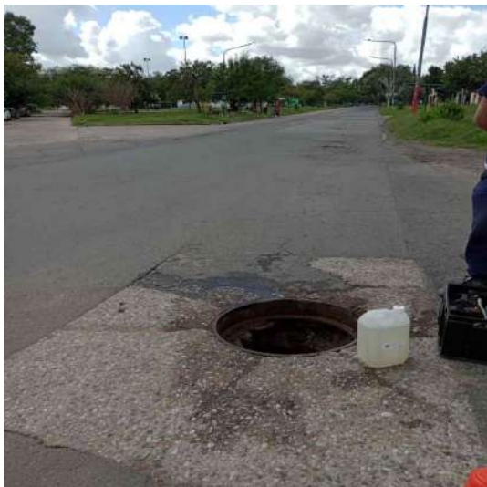
Cámara-Emisario Loureiro- Muestra N°4
