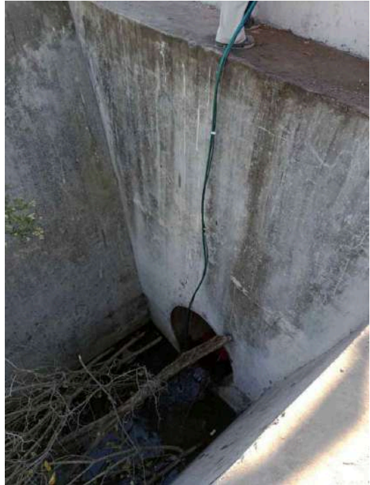
Punto EBOUS-1. Vista del emisario y ramas en su interior
