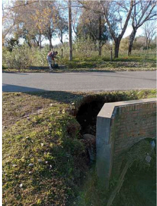
Punto ESCH-3. Vista del emisario
