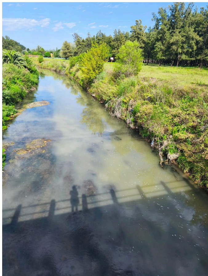
Puente Álvarez Condarco- Vista aguas arriba del punto. Fecha 02/01/2026
