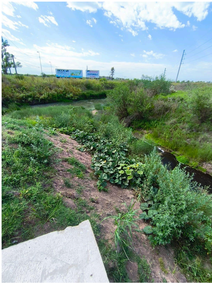
Boca de Registro de ASSA- Vista al pluvial proveniente de Funes y su descarga en el Arroyo Ludueña. Fecha 02/01/2026
