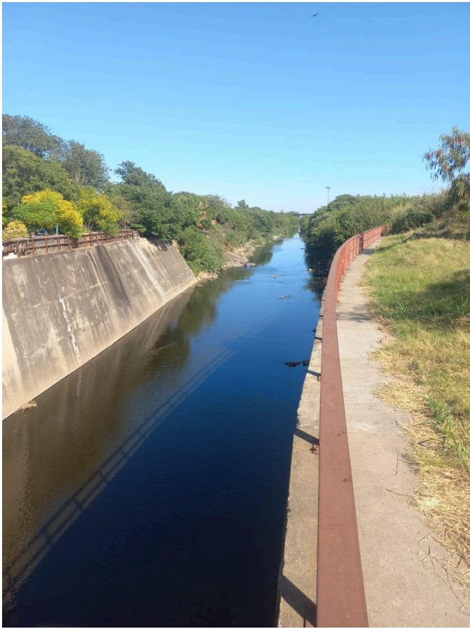
Comienzo de Entubado Arroyo. Vista hacia el cuerpo superficial. Fecha 23/01/2026
