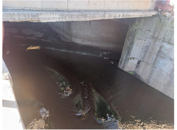
Comienzo de Entubado Arroyo. Vista hacia el entubado. Fecha 23/01/2026
