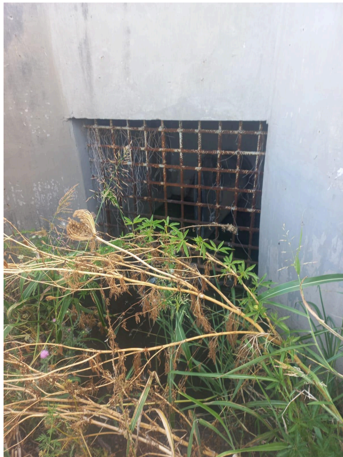
Vista hacia el conducto de descarga de la Estación Elevadora N°15 ASSA. Fecha 23/01/2026
