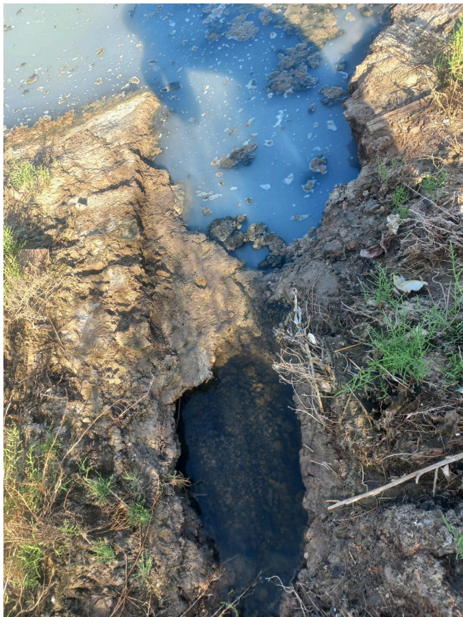
Margen del arroyo. Estación Elevadora N°15 ASSA. Fecha 23/01/2026
