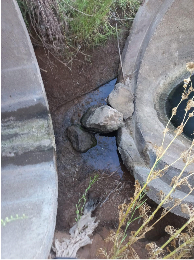
Conducto pluvial- "Los Pasos del Golf" Fecha 23/01/2026
