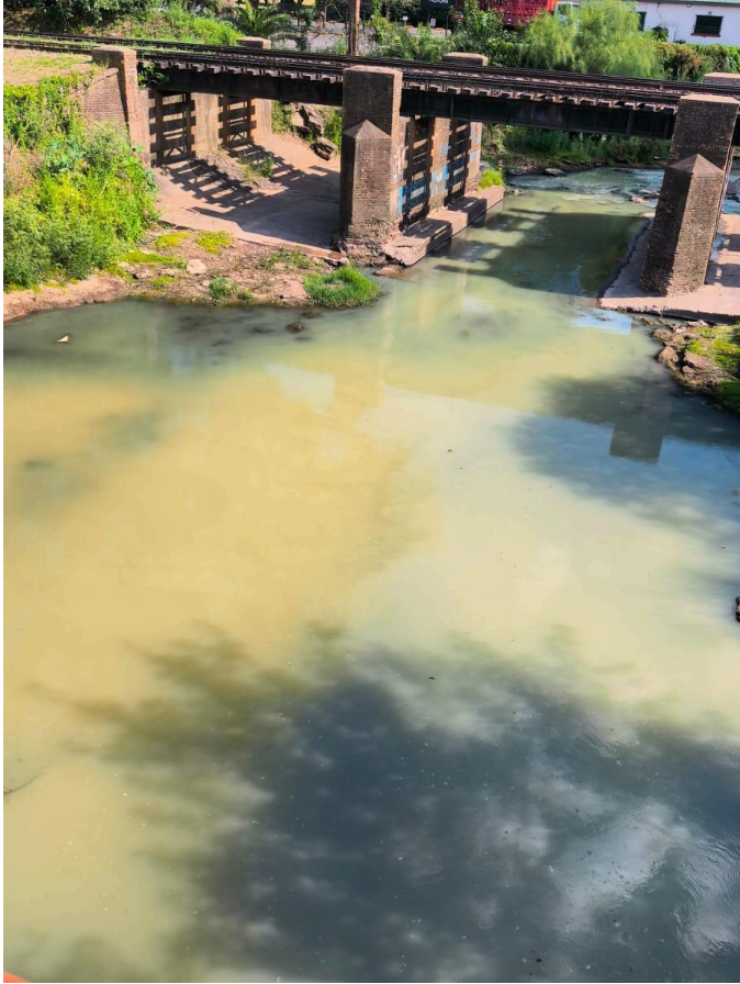
Puente Azcuénaga. Fecha 02/01/2026
