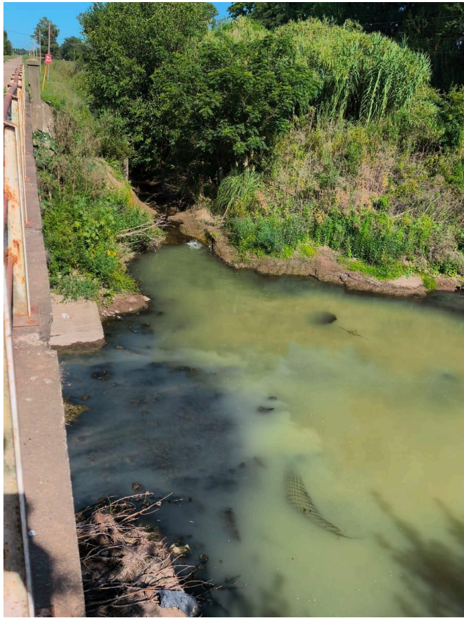
Puente Azcuénaga- Vista al pluvial proveniente del Aeropuerto Fecha 02/01/2026
