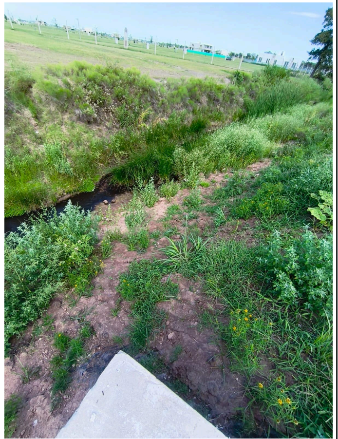
Boca de Registro de ASSA- Pluvial proveniente de Funes sin coloración. Fecha 02/01/2026
