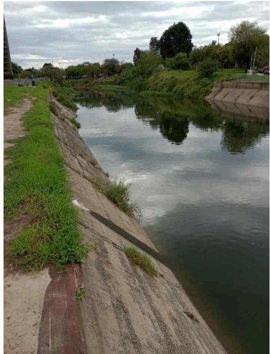
Efluente lateral zona de Av. de los Trabajadores y Allende
