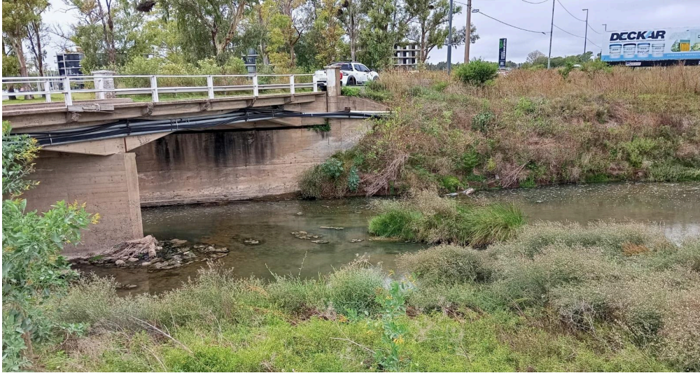
Punto II-LS-40 -Vista desde Zanja de Funes hacia Puente Miglierini
