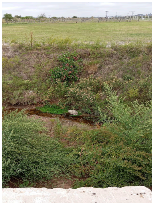
Punto II-LS-40 -Vista desde Boca Registro ASA hacia Zanja de Funes
